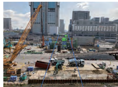
5・6街区間で環4の柱の基礎工事が進められている。「環4NEWS Vol.2(東京都第一建設事務所)から」
