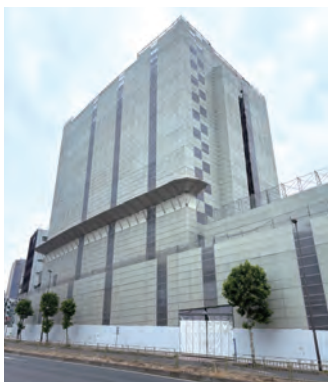
芝公園4丁目にて工事中のデータセンター
