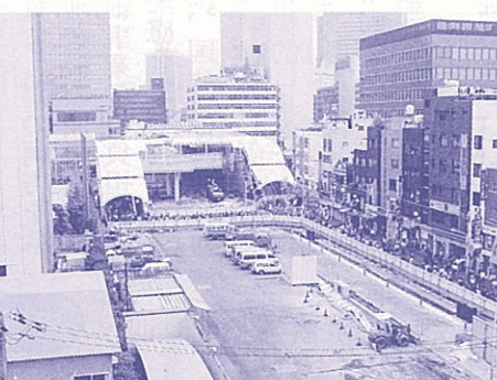
▲早期完成が望まれる田町駅前
