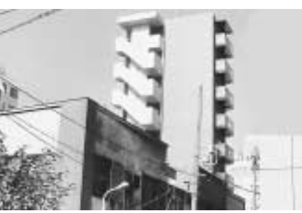
耐震偽造が明らかになった、芝大門二丁目のマンション
