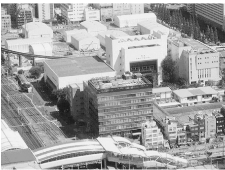
▲街づくりビジョン(案)が示された田町駅東口北地区
