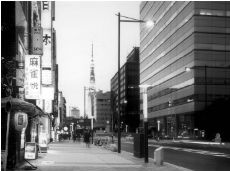
▲電線類を地中化した道路
