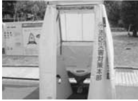
配備されるマンホールトイレ
