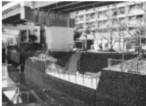
整備が進む古川の護岸
